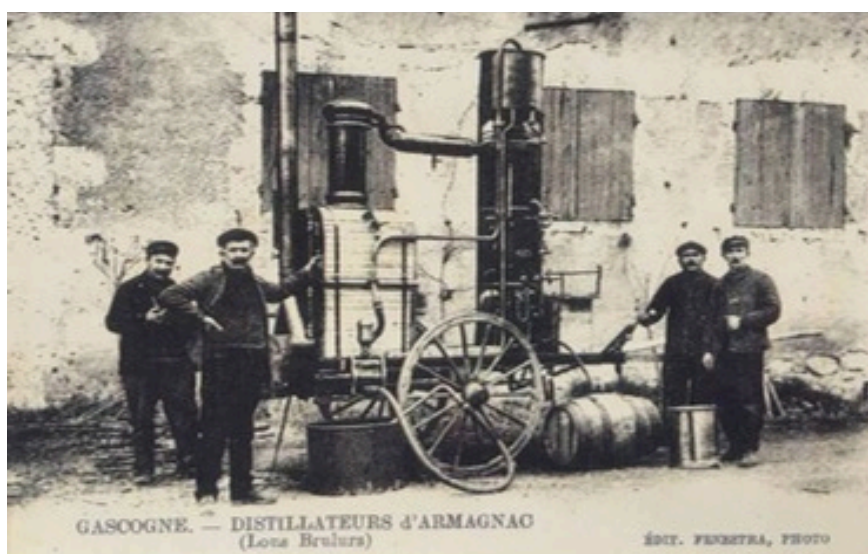
Destiladores de Armagnac operando un alambique tradicional utilizado para la producción y destilación de aguardiente de vino en la región de Gascuña, Francia.
